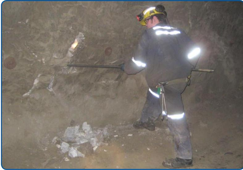
*Figure 1 : Purge du mur d'une galerie*
