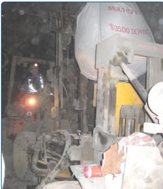
Figure 3 : Préparation de la machine à béton projeté
