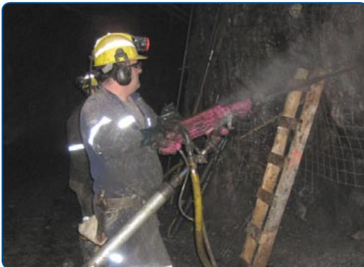
Figure 3 : Utilisation d'une foreuse sur béquille
